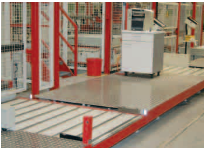
Arbeitsbereich mit rutschfesten Standflächen und ausgekleideten Rollengängen. Auf dem Verkehrsweg sind die Schienen versenkt.
