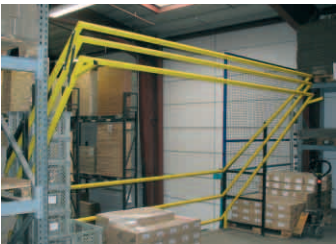
Schleusengeländer – zur Lastübergabestelle gesichert, zur Lagerbühne geöffnet
