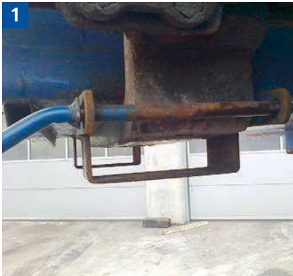
1 Arbeitsbühne gegen Abkippen und Abrutschen formschlüssig sichern (Steckbolzen mit Splint gesichert).
