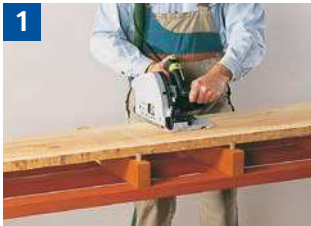
1 Sägen von Massivholz auf Unterlagen mit Anschlagknoppen.
