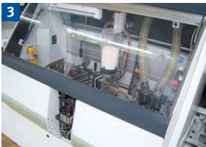
3 Sind die Gefahrstellen der Stachelwalze gesichert, z. B. mit einer elektrisch verriegelten Schutzhaube oder durch eine fest verschraubte Verkleidung?
