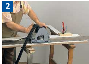
2 Sägen von Plattenmaterial mit Führungsschiene.
